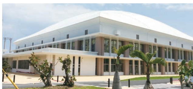
宜野湾市屋外運動場建築工事（膜屋根工事）
